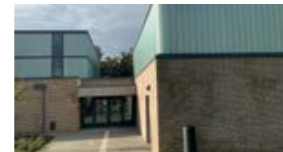
Sporthalle u. Mehrzweckr. Alte Stadtschule Bleiche 14 21423 Winsen (Luhe)
